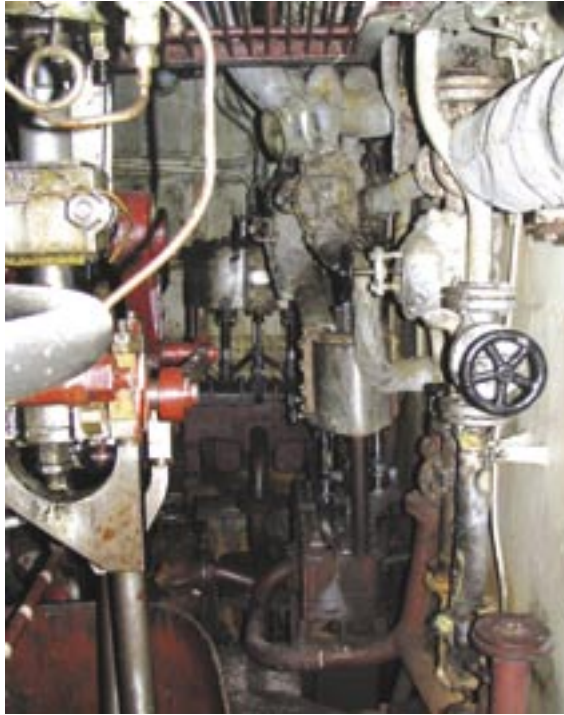
Turson konehuoneen putkiviidakon kunnostaminen ja öljyputkistojen poisto on ollut valtava operaatio. Turson kaksi kattilaa on asennettu vastakkain. Kuvat. Raimo Wirrankoski.
